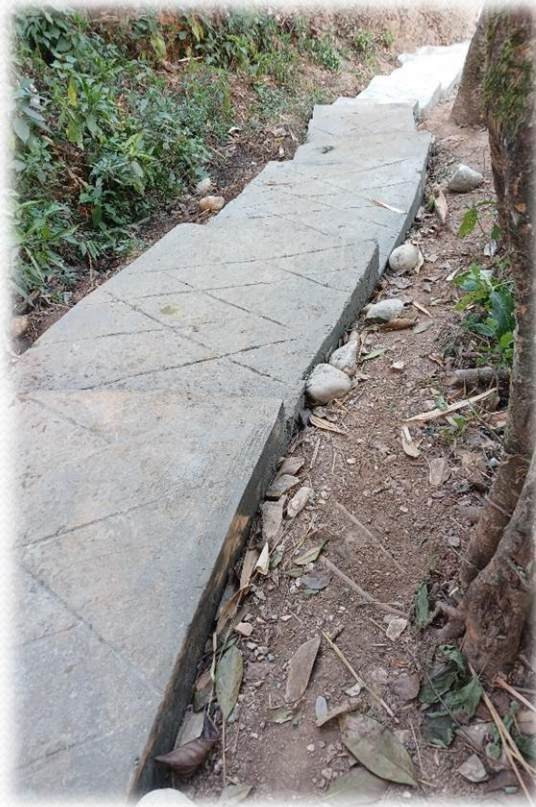
पि.सि.सि. गौरेटो बाटो निर्माण
