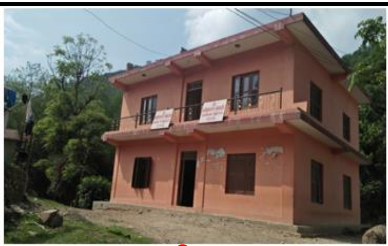
वडा कार्यालय भवन
